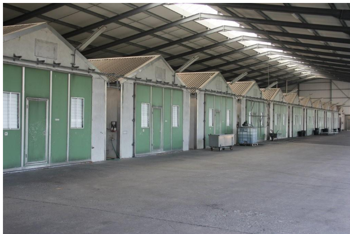
سالن پرورش قارچ دکمه‌ای با دیواره و سقف عایق
